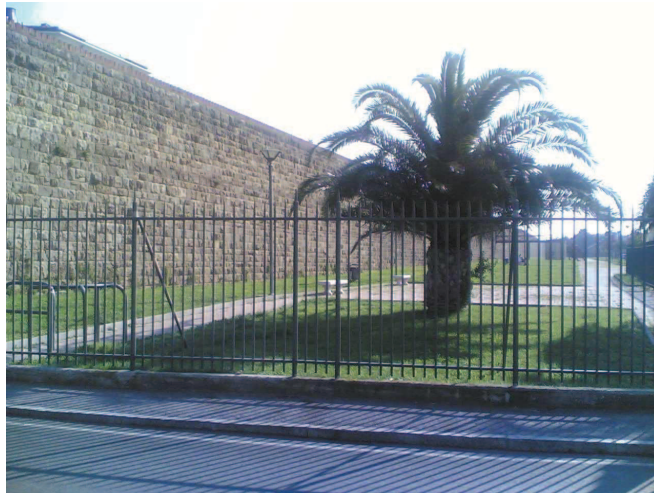
MURA LORENESI – PERCORSO DA VIA DELLA BASSATA
