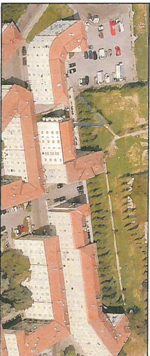
RETRO DEGLI EDIFICI DI VIA BRUNO DA VIA DODOLI
